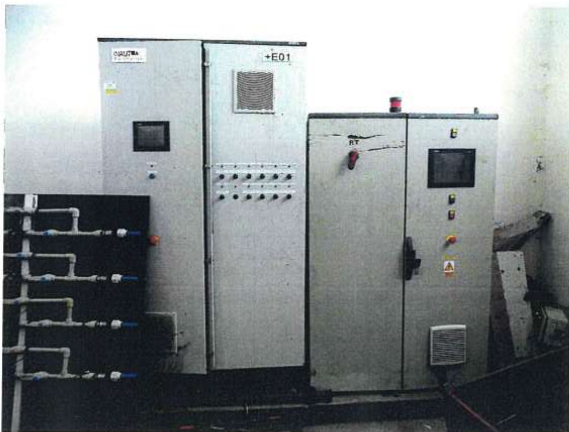
9. Szafa sterownicza linii sortowniczej LSz43/R3BW 295/7 i szafa sterownicza modułów kompostujących
