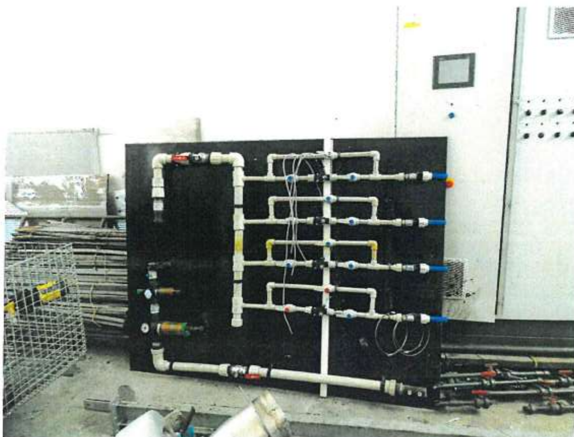
10. Panel zraszania kompostowni odpadów organicznych
