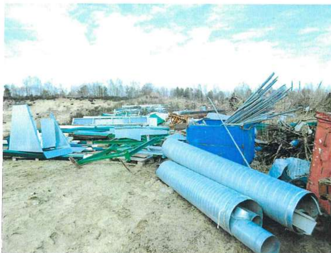
12. Zdemontowane elementy instalacji wentylacji (kanały wentylacyjne) z linii sortowniczej oraz inne elementy konstrukcji i wyposażenia obiektów
